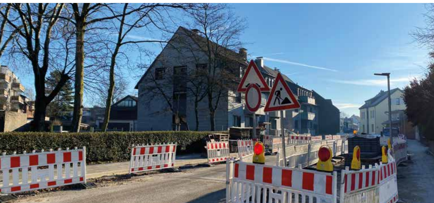
Die Straße Heiderhöfen ist noch immer nur eingeschränkt befahrbar. Dort wurden und werden von der Bebelstraße bis hin zum Fröbelplatz Kanal- und Straßenbaumaßnahmen durchgeführt. Foto: Peter Klunk
