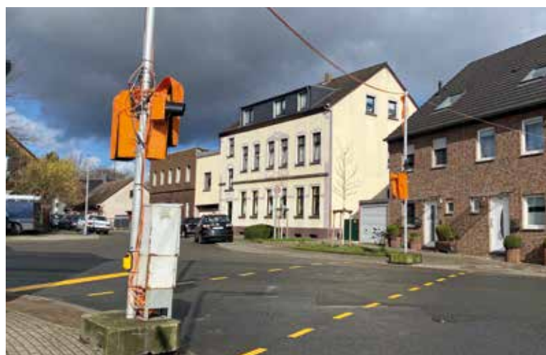
Bereits im März wurden vorbereitende Arbeiten im Bereich Kewer-/Bebelstraße durchgeführt. Foto: Peter Klunk
