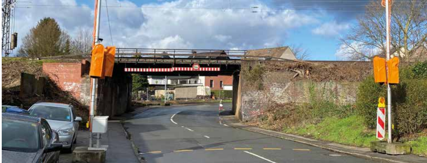
Ende September sollen die Brücken an der Kewer- und an der Speldorfer Straße abgerissen werden. Foto: Peter Klunk
