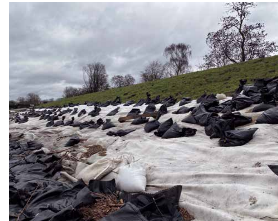
Während des Hochwassers an Weihnachten 2023 musste der Deich entlang des Ruhrparks zusätzlich gesichert werden. Foto: Dagmar Kotschy
